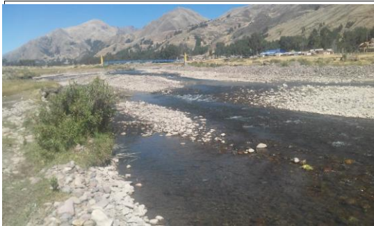
FOTO 01: Se aprecia el curso del agua del río Vilcanota las margenes derecha e izquierda se encuentran afectados por erosión y colapso por tramos, sin defensa riberaña talud natural, así mismo cauce colmatado. comunidad campesina de Chauchapata y Sencca Chectuyoc, Distrito de Sicuani.
