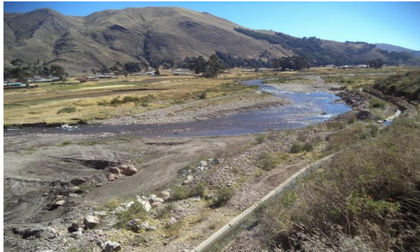
FOTO 04: Sección hidráulica variable, se aprecia en la ribera de la margen derecha aguas abajo COMUNIDAD CAMPESINA DE TRAPICHE, afectado la ribera margen derecha y cauce colmatado y se aprecia el canal de irrigación Trapiche.
